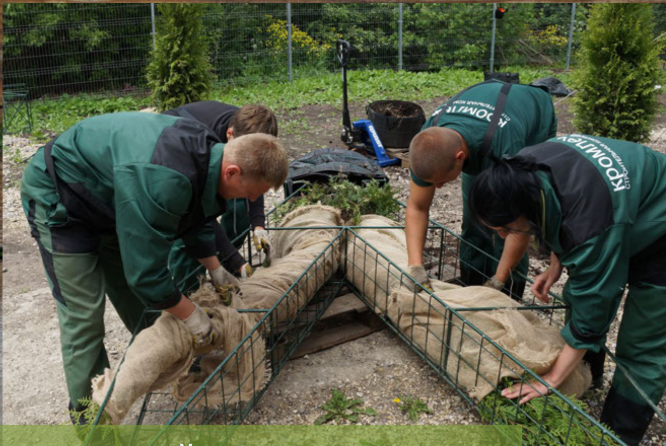
Размещение туй внутри каркаса
